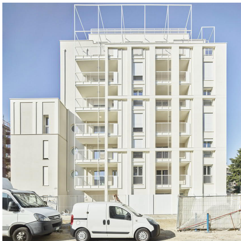
Casa Calipso in costruzione
